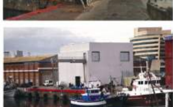
Nueva construcción de la fábrica de hielo. Edificio dedicado a la creación del hielo necesario para el pescado. Desde que se pesca hasta que se subhasta en el mismo muelle.
