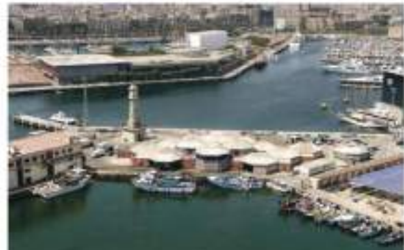
Cofradía actual del "Moll dels Pescadors". Estructura actual aun existente frente a la torre del reloj. Este edificio se forma con la superposición de elementos hexagonales, cuya estructura se sostiene mediante pilares interiores.
