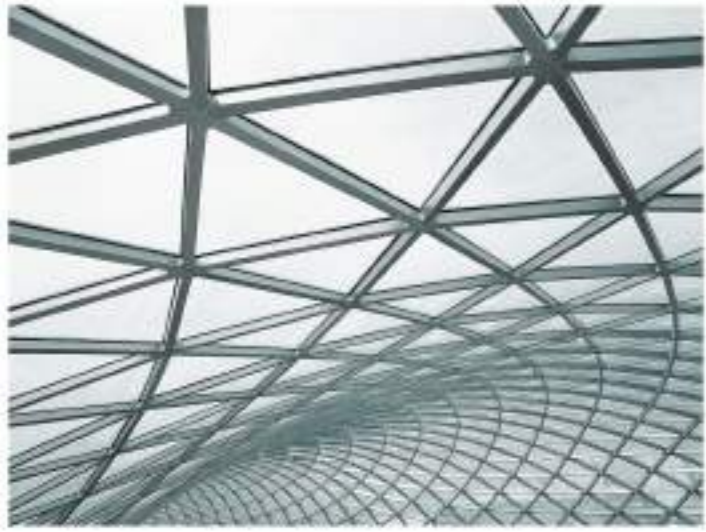
Estructura de perfils tubulars metàl·lics
