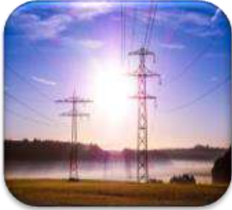
Grau en Enginyeria Elèctrica (EEBE, ESEIAAT, EPSEVG)
